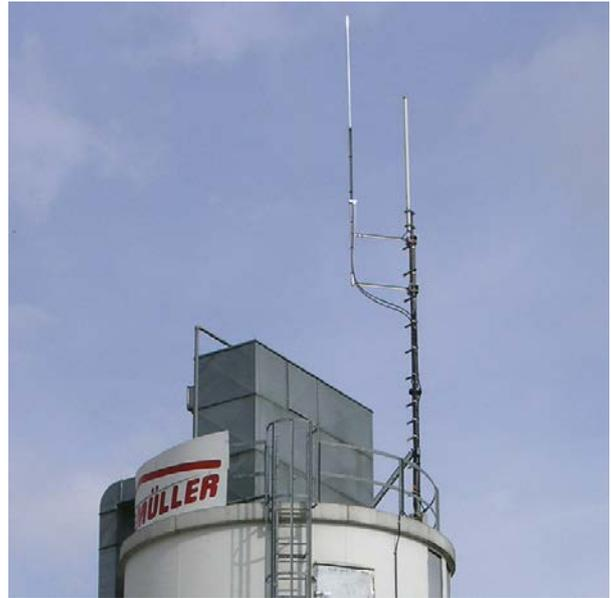
Abstandshalterung für DEHNiso-Combi-Stützrohre mit innen- und / oder außenverlegter HVI Leitung, montiert am Antennenmast. Befestigung erfolgt mittels Spannband.
