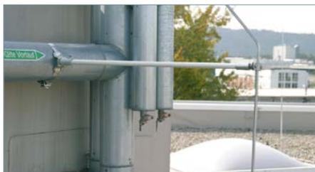
Distanzhalter mit Aufsatz, Befestigungsbuchse und Spannband.
